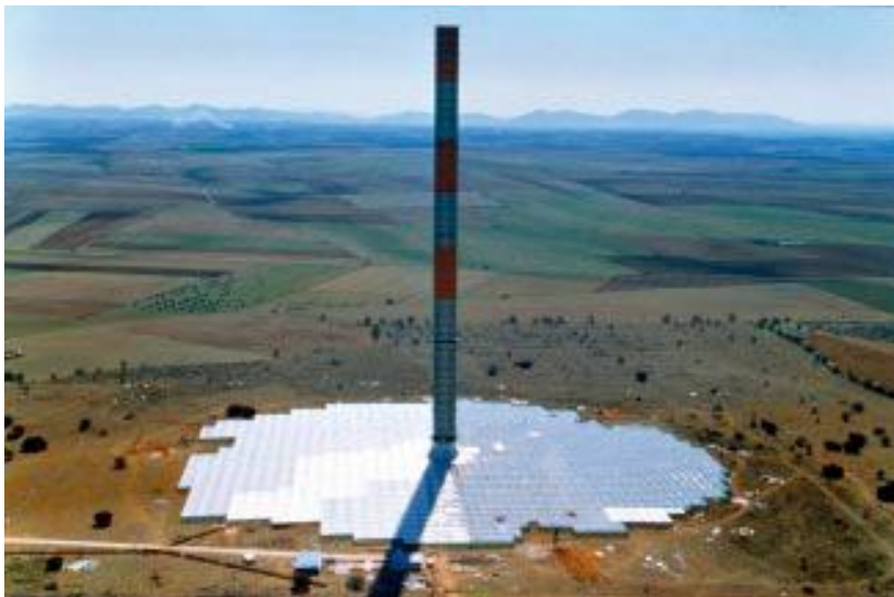
Fig. 1.1 – Protótipo de Chaminé Solar construído em Manzanares, Espanha. [3]
