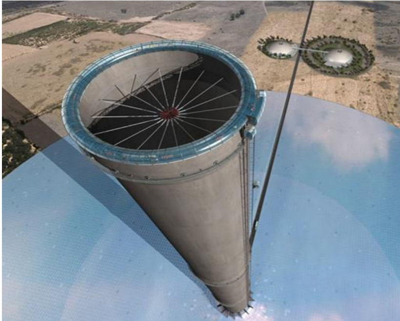
Fig. 2.7 – Ilustração da torre da chaminé solar, com anel de reforço. Fonte: EdRB
